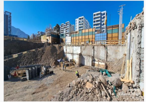
30 de junio de 2026 — Muros pantalla y entorno urbano consolidado
