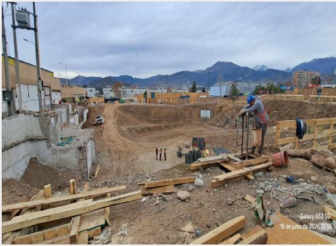
16 de junio de 2026 — Excavación e instalación de faenas
