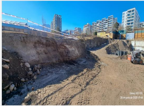
30 de junio de 2026 — Avance de excavación y muros de contención
